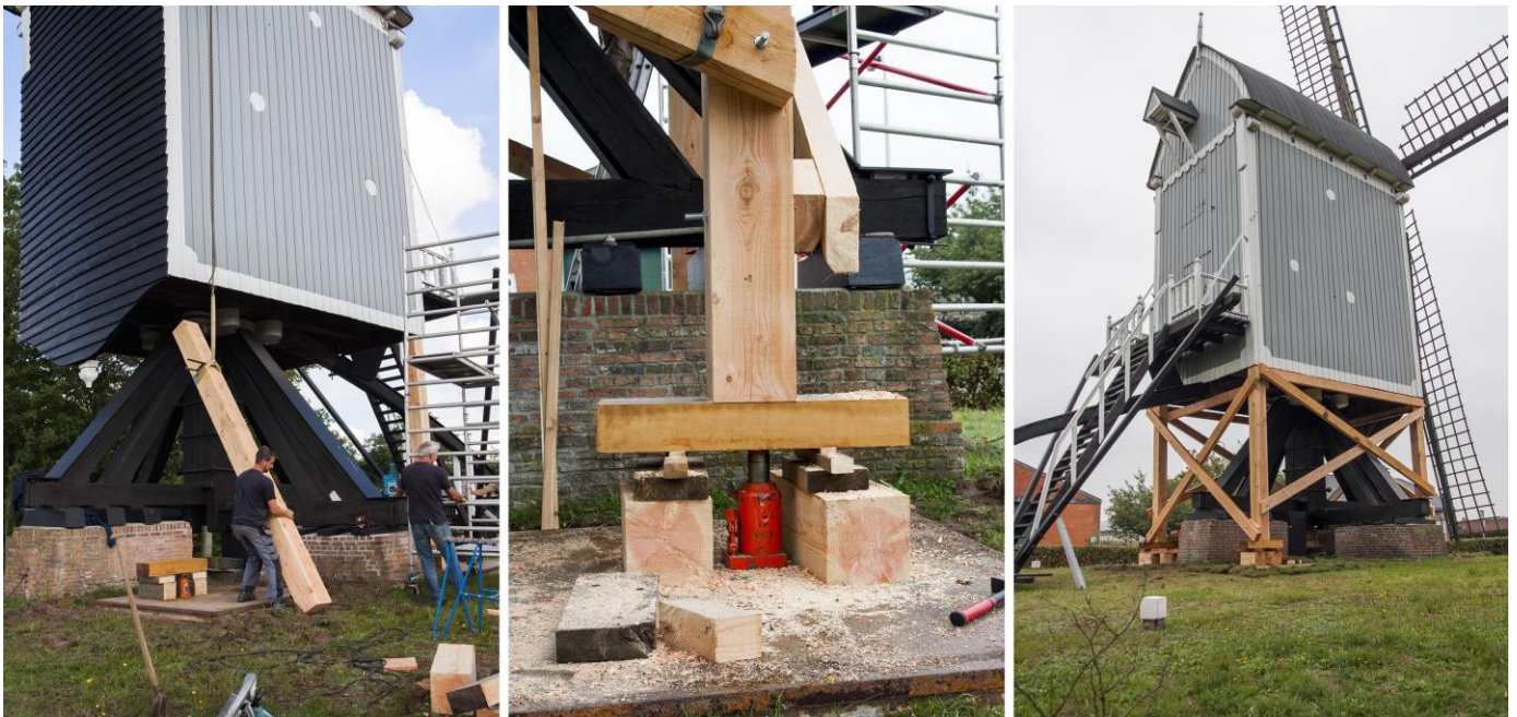
Foto's van het stutten van de Akkermolen (foto's gemaakt door molenaar Jac Brosens).
